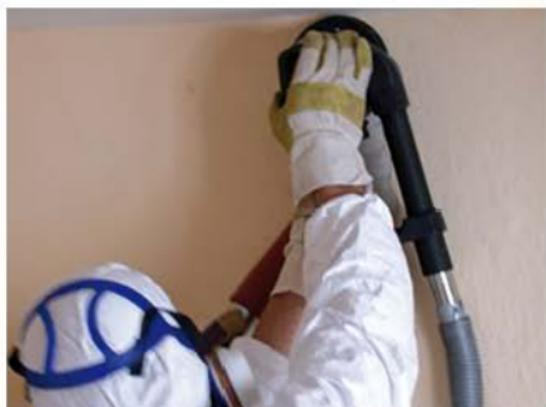
Schimmelpilzsanierung mit Putzfräse
